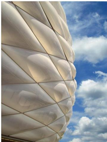
Bauwerke, denn die nur 0,2 - 0,3 mm dicken Folien werden oft Opfer von „Pickattacken“. Klebebänder aus ETFE-Folien verschließen dauerhaft diese Löcher – und das unsichtbar über bis zu drei Jahrzehnte.
